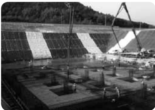
▲ 본청 A1구간 기초 콘크리트타설 및 T/C 설치(2012년 5월)
