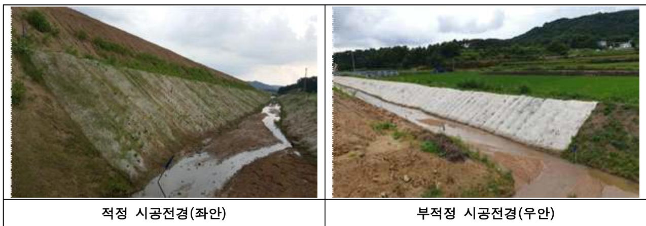
[사진 1] △△△△ 시공 현황
