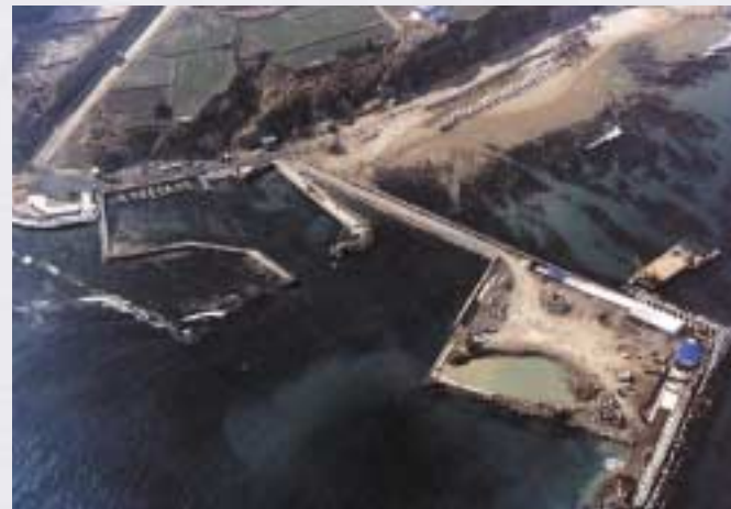
▲ 포항영일만 신항건설 현장
