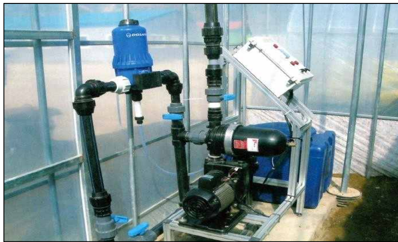
그림 20. 반자동의 양액 시비 시스템
