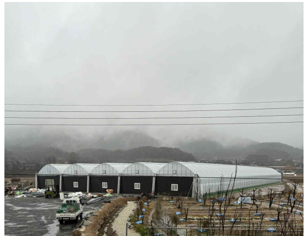
경주형 연동하우스 설치전경(내남면)
