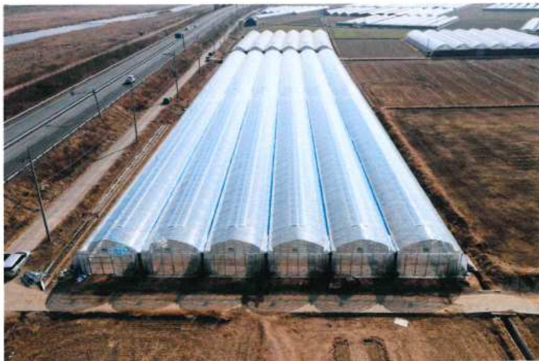
경주시는 스마트팜 기능이 가능한 저비용 시설인 '경주형 연동하우스'를 오는 2025년까지 지역 시설재배 농가 30개소에 보급키로 했다.사진은 경주형 연동하우스 외부 전경.
