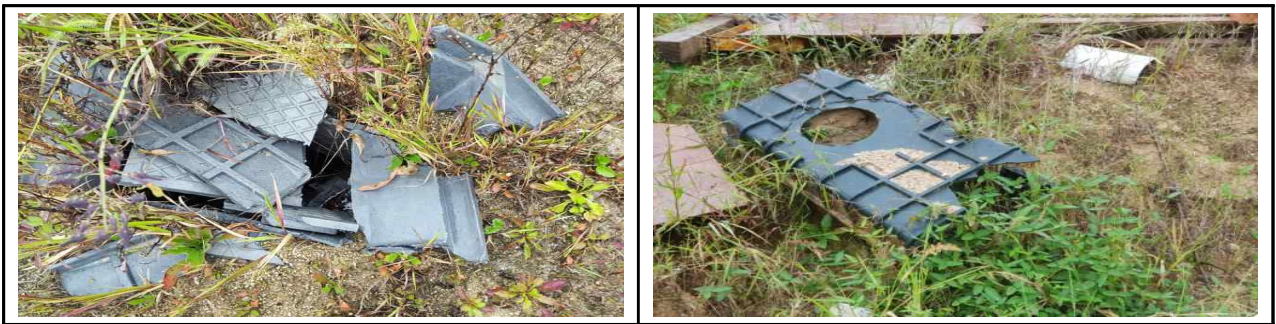
〔그림4〕 신도시 1단계 오수받이 설치 전경
