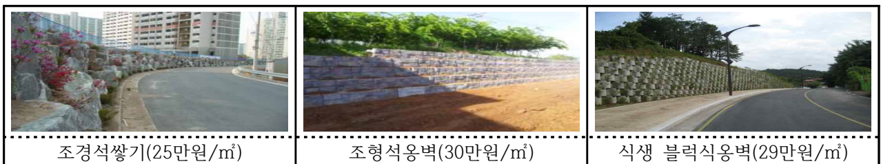
[그림3] 절·성토 구간에 적용될 수 있는 구조물 공법 예시
