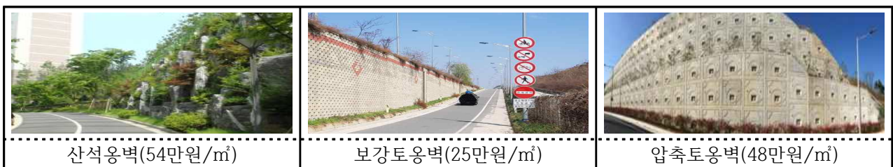
[그림1] 신도시 2단계에 적용된 옹벽구조물 공법
